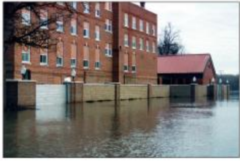
Hình 10: Tường chắn bảo vệ trường Oak Grove Lutheran trong trận lũ năm 2001
