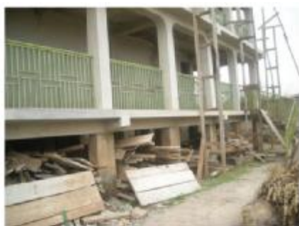
Hình 13: Xây nhà trên cọc chống tại Kumasi, Ghana
