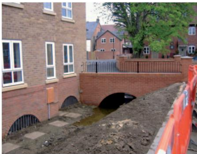
Hình 30: Hệ thống ngăn nước
