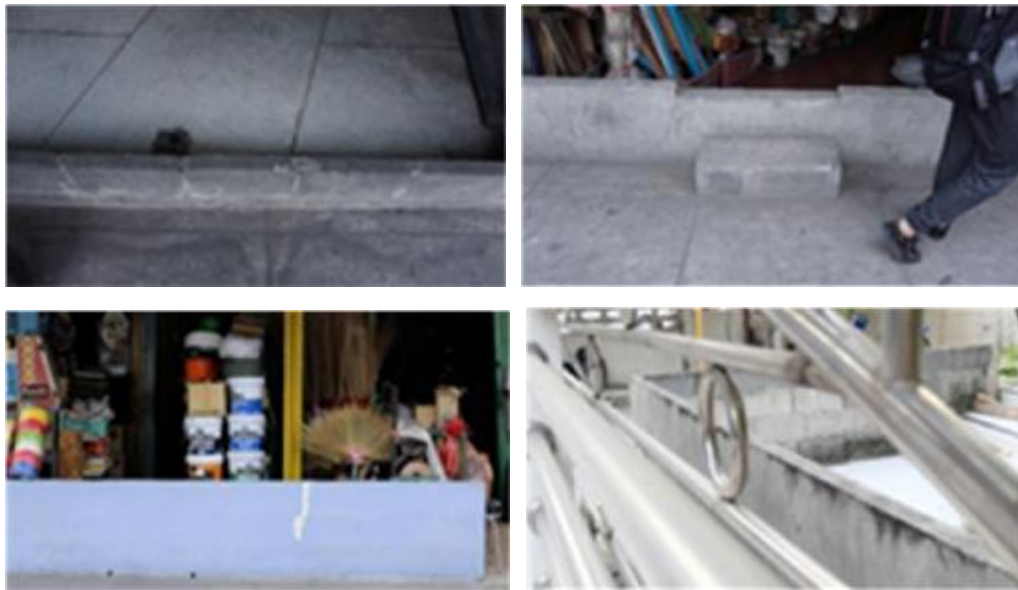
Hình 8: Nhà dân tại hẻm Lasal, Thái Lan xây tường chắn chống ngập trước nhà
