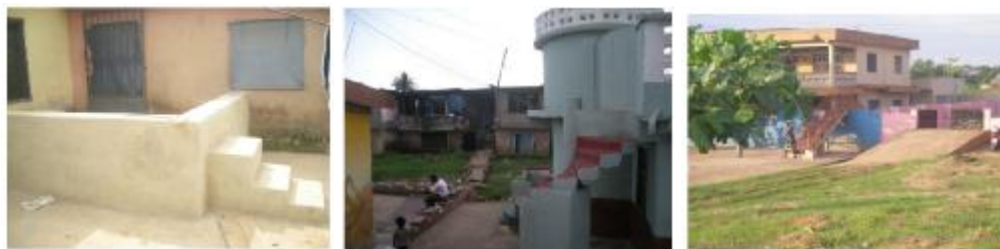
Hình 9: Nhà dân thích ứng với ngập lụt bằng cách xây tường chắn và lối đi ở Ghana
