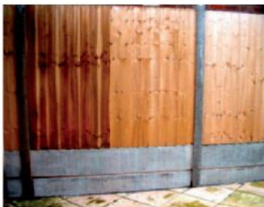
Hình 31: Vật liệu chống thấm nước cho hàng rào
