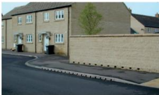
Hình 34: Hệ thống thoát nước với các lỗ hồng trên tường và trên mép đường
