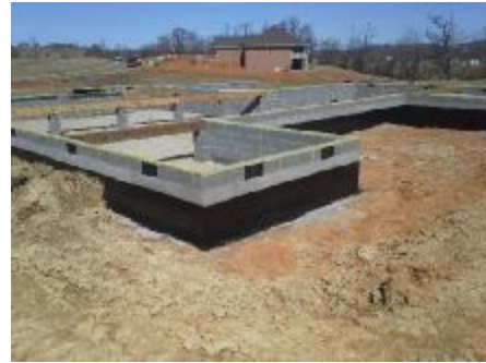
Hình 4: Nền móng một căn nhà theo cách cho nước tràn vào nhà
