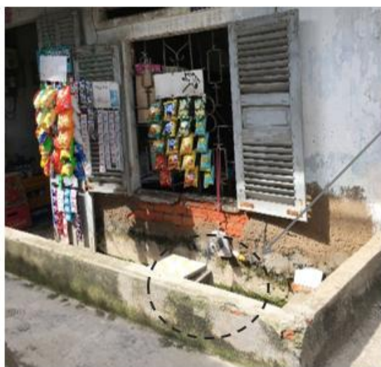
Hình 39: Giải pháp xây bậc chắn nước tại KP 3, Phường 16, Quận 8.
