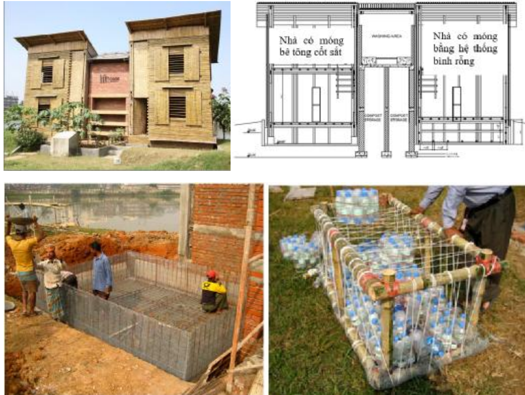
Móng bê tông cốt thép
