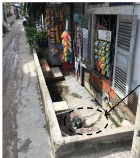
Hình 42: Giải pháp đặt máy bơm tại rãnh thoát nước trước cửa nhà tại KP 3, Phường 16, Quận 8
