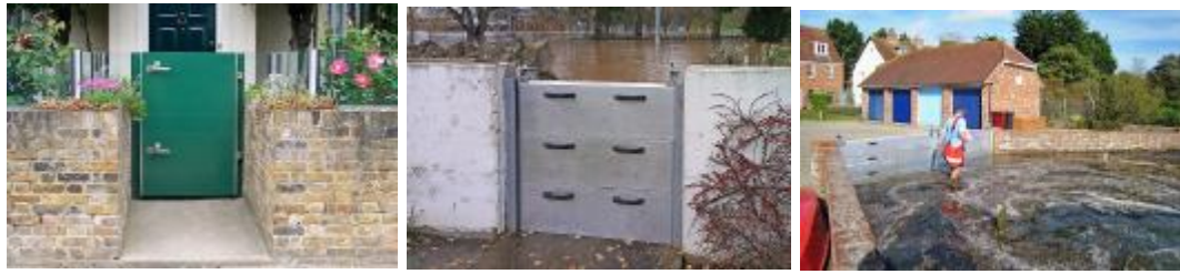
Hình 7: Các hình mẫu nhà áp dụng cách tiếp cận chặn nước ngập
