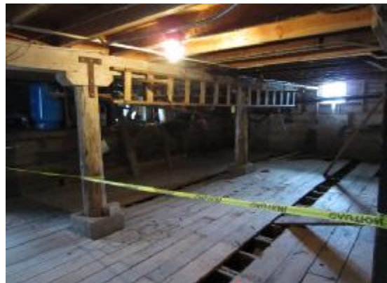
Hình 2: Nhà có tầng trệt được nâng lên
