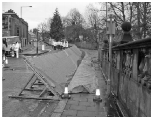
Hình 32: Rào chắn lũ tạm thời được triển khai tại Cologne, Đức
