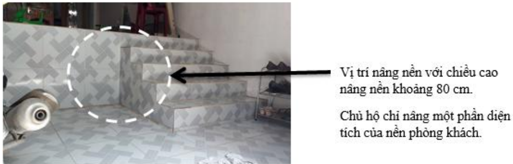
Hình 37: Giải pháp nâng nền nhà tại KP 3, Phường 16, Quận 8
